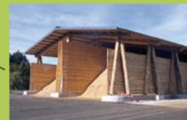
Plateforme de stockage de plaquettes forestières du canton de Morez ARCHITECTE : GEORGES LADOUY
