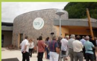
Maison de Santé de Moirans-en-Montagne ARCHITECTE : ÉLIE BOUCHE
