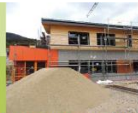
Construction d'un ensemble scolaire et périscolaire à ARCHITECTE : PHILIPPE PAILLARD
