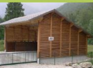
Plateforme de stockage de plaquettes forestières du canton de Chézery-Forens ARCHITECTES : JEAN-PIERRE BAILLET ET FABIEN GEORGET
